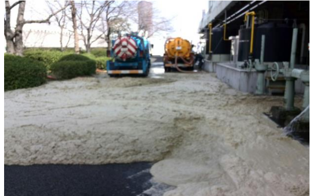
図4 スカミングによる処理機能障害（東京都）
