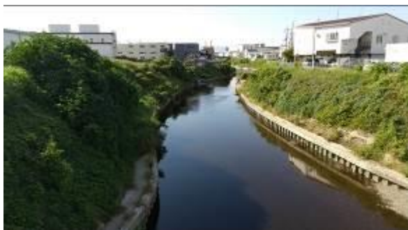
石津川での調査
