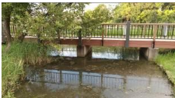
狭山池副池の親水公園での調査
