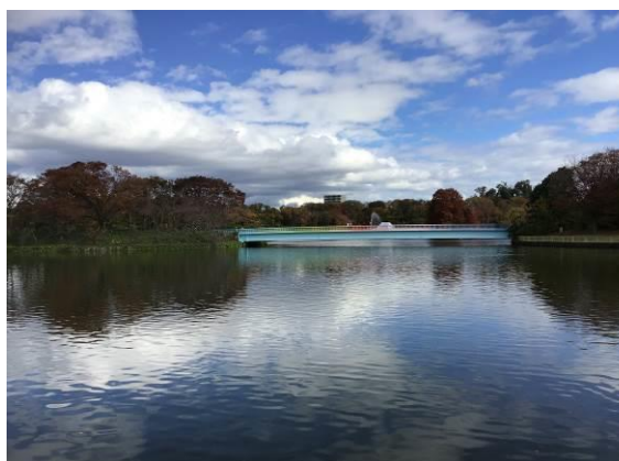
長居公園内の池の目視による調査
