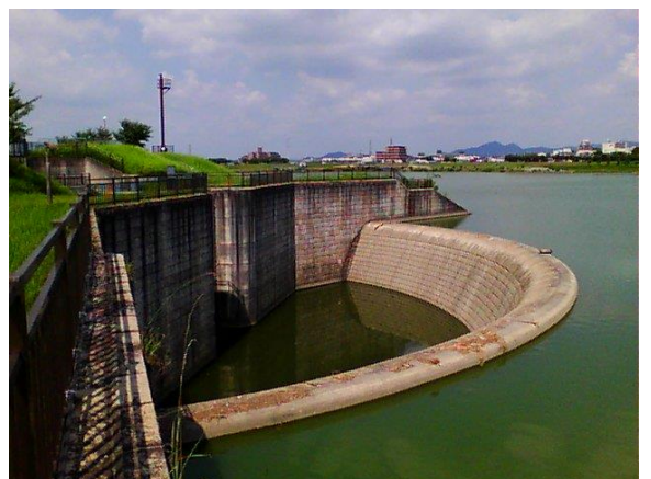
図 3.3.9 狭山池ダムの調査
